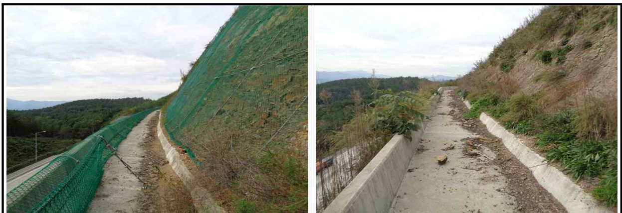
【그림 10.3.3】 배수시설 전경
